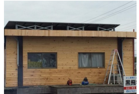
H28.5.7 間伐材で側壁作り
